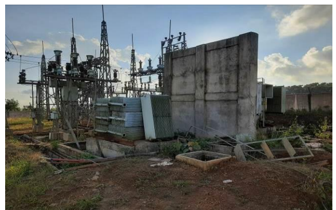
Fire Wall at 33/11 kV Mynkre and Latyrke S/S
