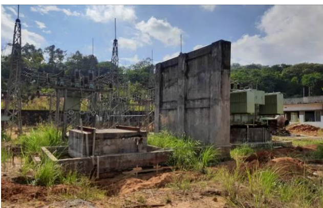
Fire Wall at 33/11 kV Mynkre and Latyrke S/S
