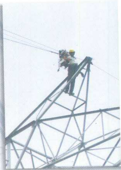
OPGW Cabling in Live-Line
